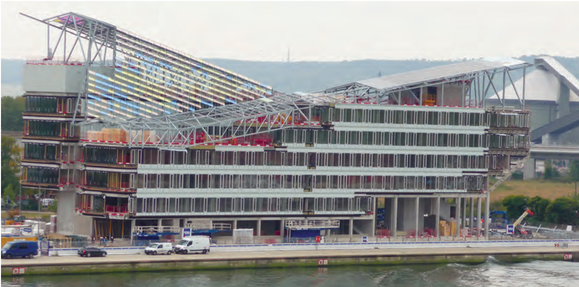
Une structure en béton revêtue d'une double peau : mur-rideau avec des lames de couleur ou panneaux photovoltaïques (crédit photo : Philippe Outrequin)
