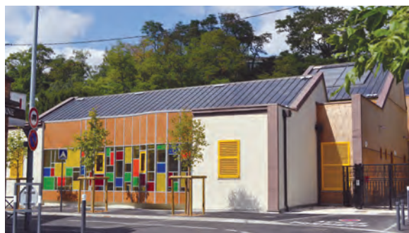
Des panneaux solaires et photovoltaïques intégrés à la toiture (crédit photo : Altana Architectures)
