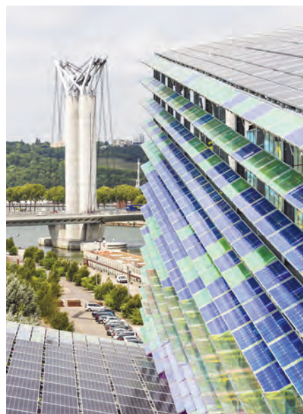
Les écailles de verre se mêlent aux panneaux photovoltaïques (crédit photo : Luc Boegly)
