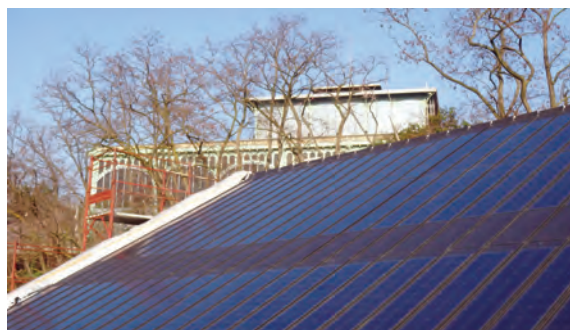
Des panneaux solaires et photovoltaïques intégrés à la toiture (crédit photo : Altana Architectures)
