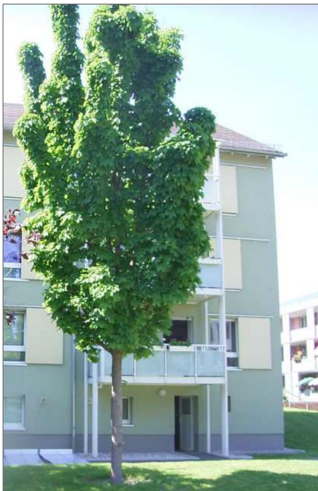
La moitié de l'année comme au début du mois de juin... Rénovation dans l'ancien qui a été réalisée avec des composants de la maison passive. Photo prise en mai 2005 (Photo WF)
