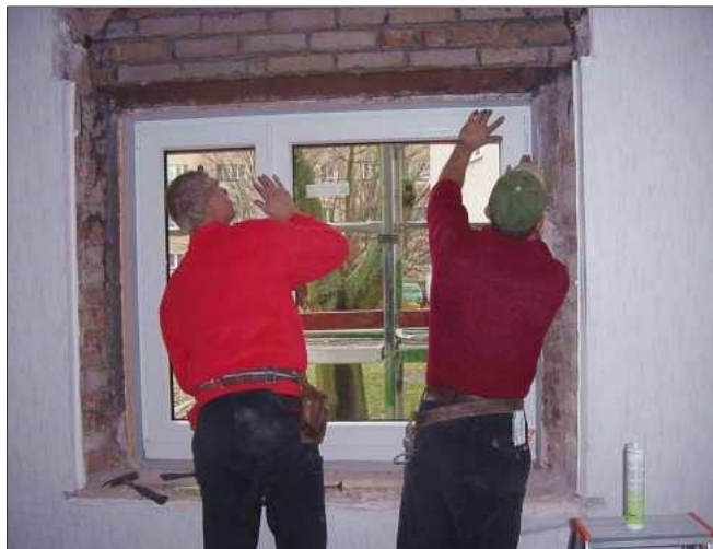
Et la fenêtre est déjà posée: une fenêtre maison passive avec un triple vitrage, un montage et un châssis très isolé. Cette fenêtre garantit pour les 50 prochaines années une qualité excellente.
