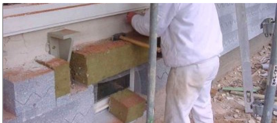
Photo de chantier: réalisation d'une isolation de 200 mm d'épaisseur. A chaque fois au-dessus des fenêtres, il y a une bande d'isolant en laine minérale ininflammable. (Photo: Schulze-Darup)
